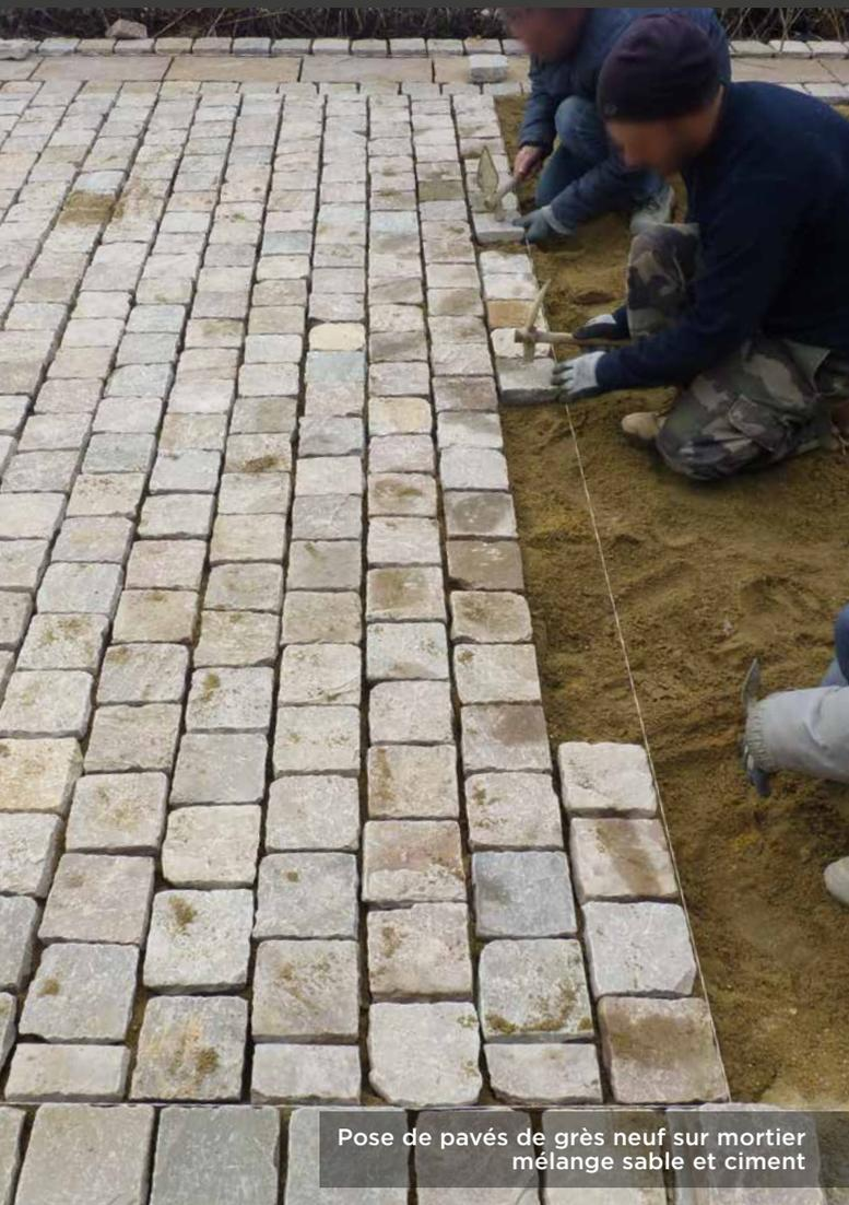
Pose de pavés de grès neuf sur mortier mélange sable et ciment
